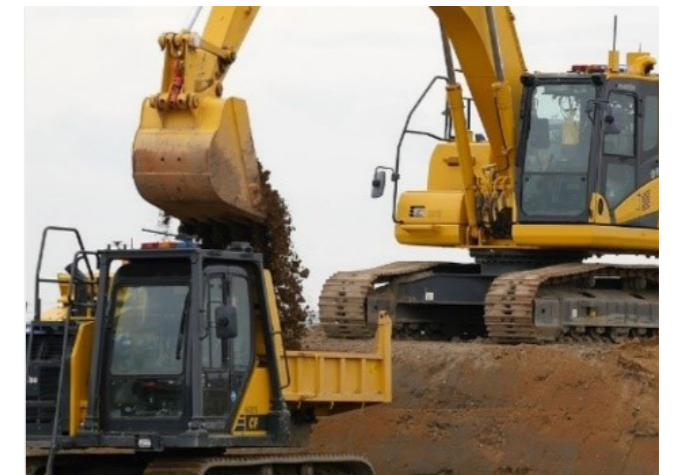
協調・自律稼働する建機のデモンストレーション(2018年10月、「CEATEC JAPAN 2018」にて)。完全無人の油圧ショベルとクローラードンプが、自律的に掘削・旋回・積込みを行い、指定場所に運搬・排土する模様をご覧いただきました。
